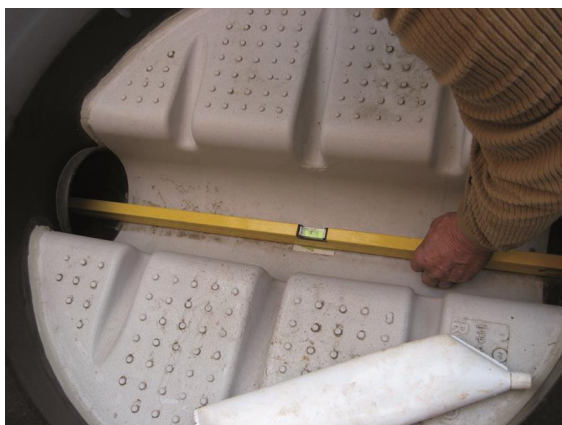
Slika 3 i 4: Kontrola položaja odvoda
